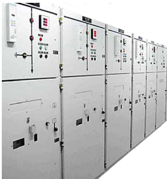
Figura 2 - Esempio di quadro MT (Norma CEI/EN 62271-200).
